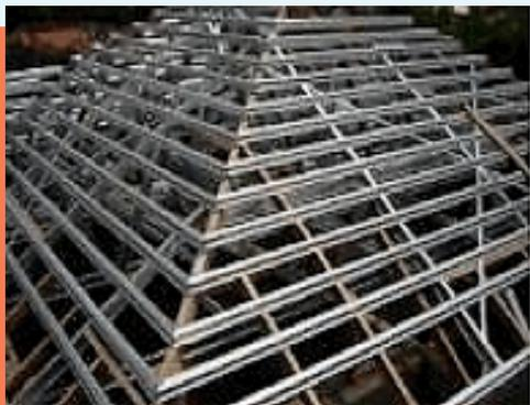
Gambar 5.2 Struktur Rangka Baja Ringan
