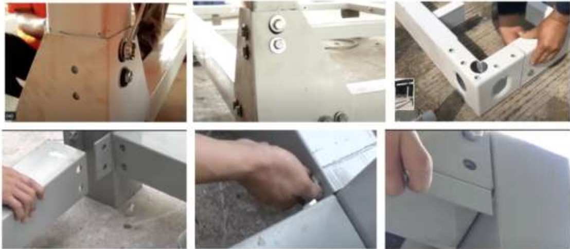
Gambar 40. Teknik sambungan baja untuk sistem modular
